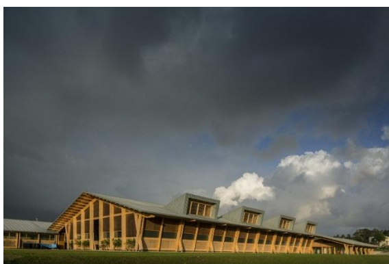
Figura 09: Vista externa da edificação
