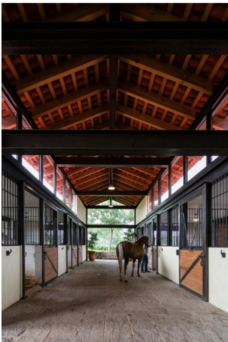
Figura 03: Vista das madeiras utilizadas.
