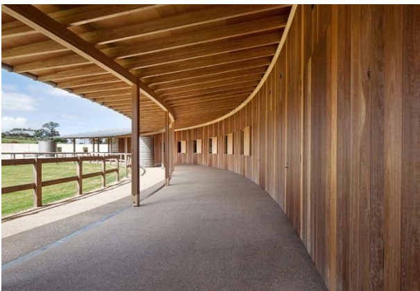
Figura 13: Revestimento em madeira
