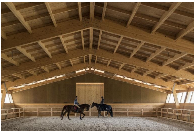
Figura 07: Vista interna da estrutura
