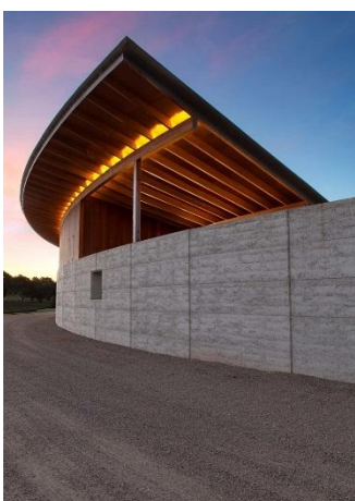
Figura 10: Vista lateral da edificação
