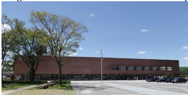
Imagem 20 – Fachada com blocos de concreto pintados
