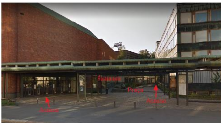
Imagem 4 – Fachada Casa da Cultura de Helsinki
