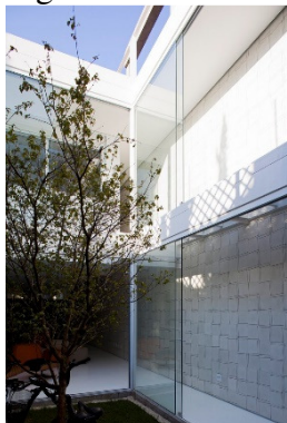
Figura 24 – Estrutura metálica aparente.
