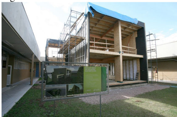
Figura 29 – Sistema construtivo Wood Frame .
