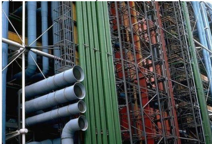
Figura 22: Estrutura e tubulações Centro Georges Pompidou
