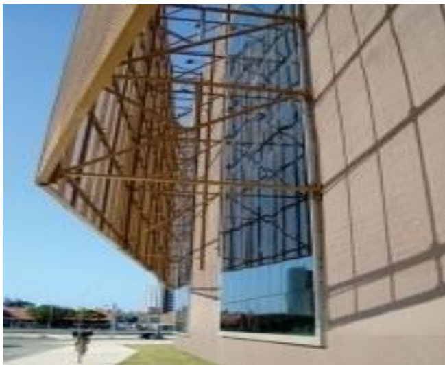
Figura 10: Placas escoradas em estrutura de aço.
