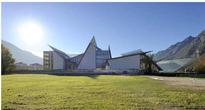
Figura 19: Fachada dos fundos do Muse
