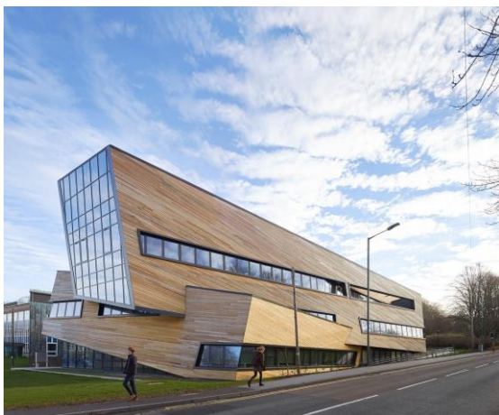
Figura 14: Fachada da Universidade Ogden Center
