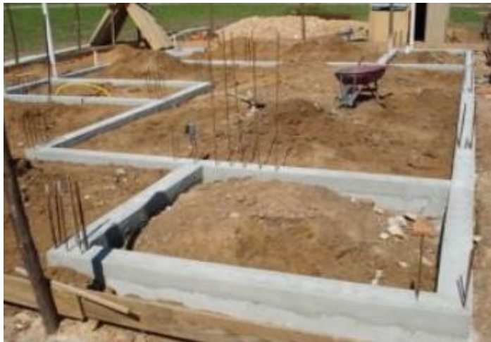
Figura 2 – Sapata Corrida
