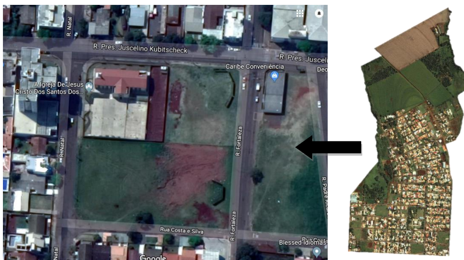
Figura 32: Vista área do bairro Recanto Tropical e do lote, entre as ruas Natal e Fortaleza.
