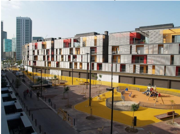
Figura 22: Fachada interna do Conjunto Fira, com vista para a praça interna.
