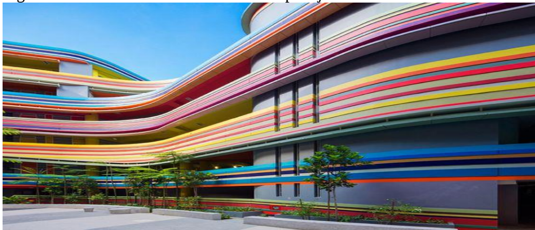
Figura 21: Passarelas viram ao mesmo tempo lajes
