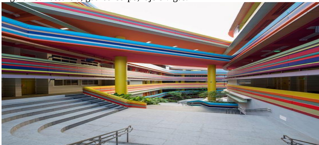
Figura 23: Passarela, guarda-corpo, laje e vigas.
