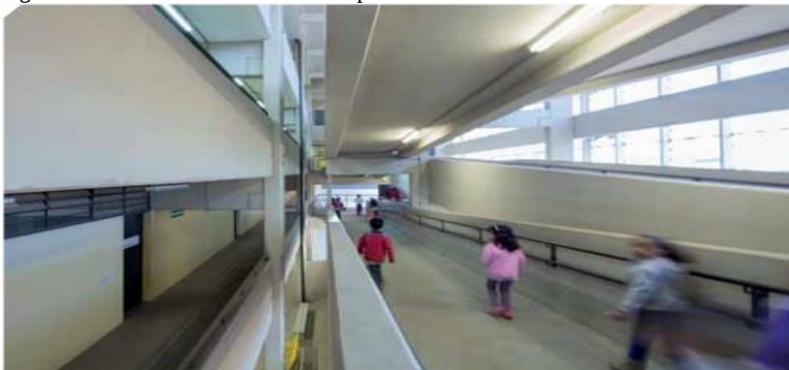
Figura 03: Obra de acessibilidade feita pela FDE
