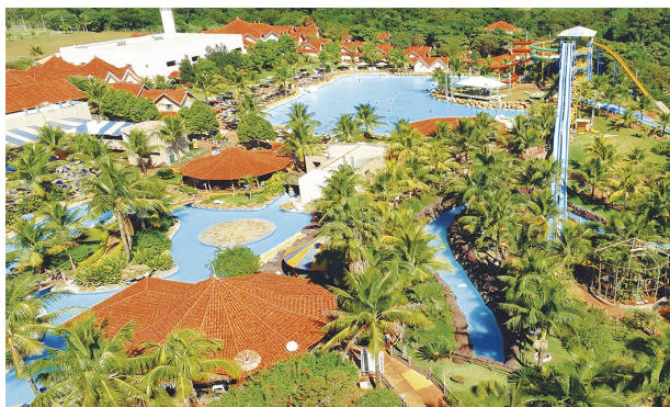
Figura 03: Vista Aérea. Ody Park Aquático.
