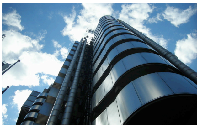
Figura 13: Edifício Lloyd's Of London, Fachada em aço.
