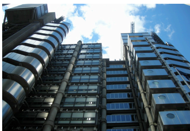
Figura 11: Edifício Lloyd's Of London, Londres, Reino Unido.
