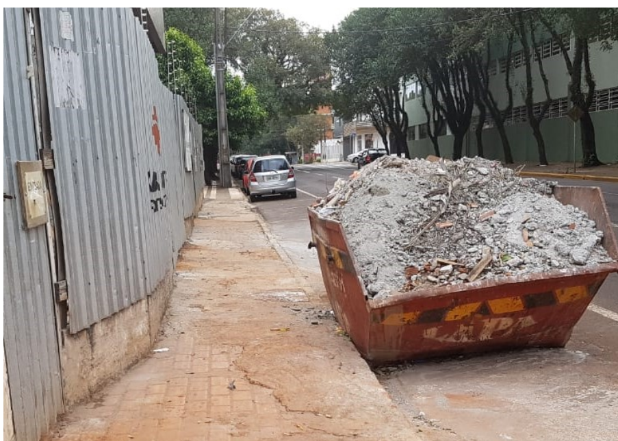
Figura 6 - Caçamba de entulho
