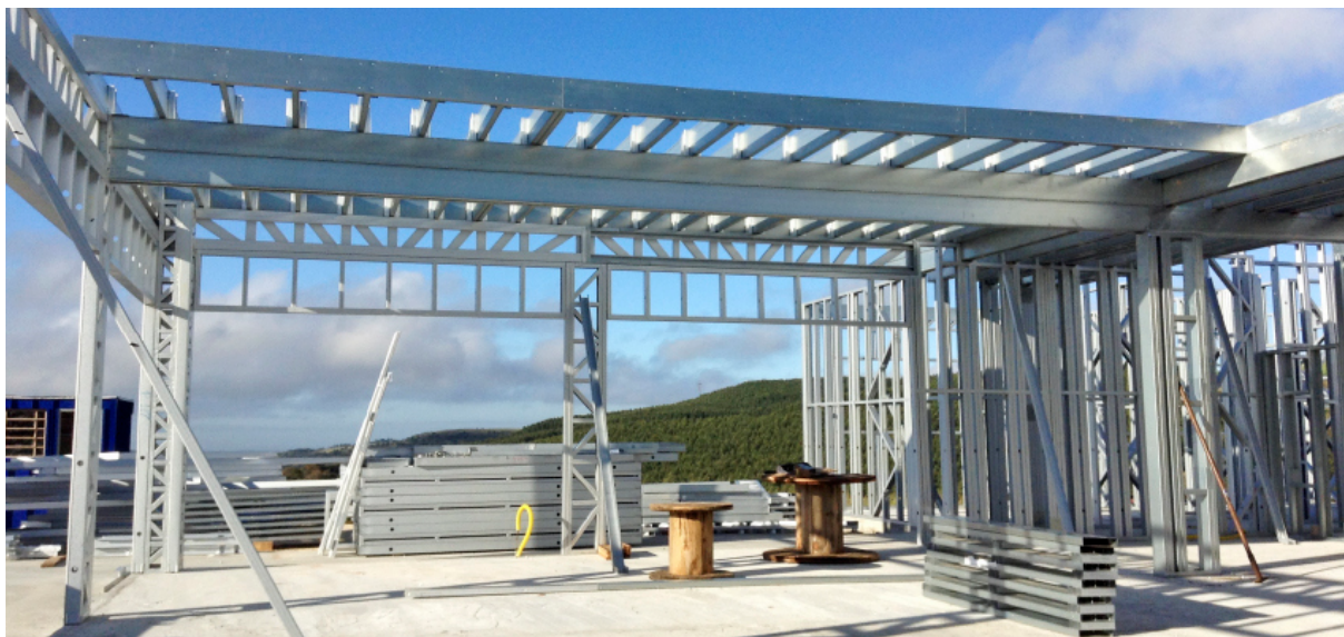
Figura 10 - Montagem da Estrutura em LSF
