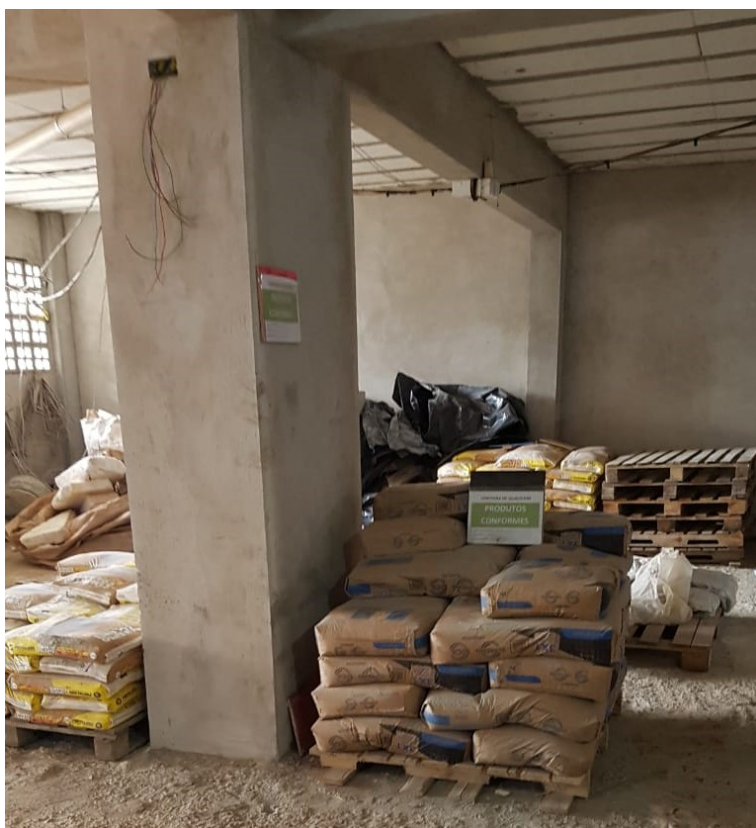
Figura 4 - Armazenamento de Cimento conforme PBQP-H
