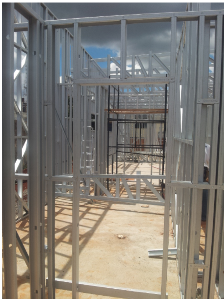
Figura 15 - Canteiro de Obra LSF
