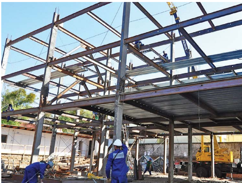
Figura 19 - Montagem da Estrutura Mista
