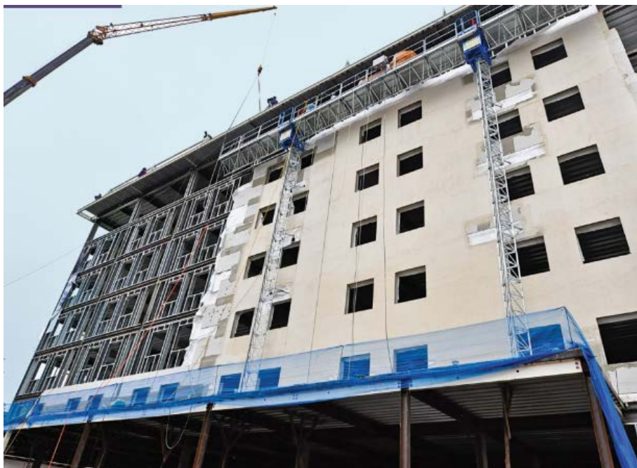
Figura 21- Fechamento em Placa Cimentícia
