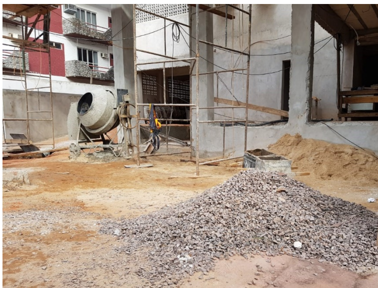
Figura 3 - Armazenamento de areia e brita, próximo à betoneira
