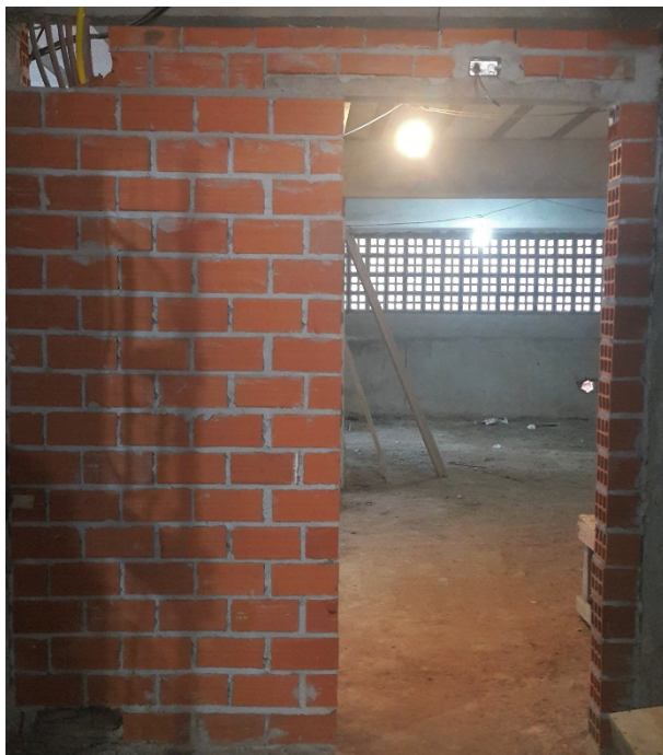
Figura 2 - Vedação em Alvenaria
