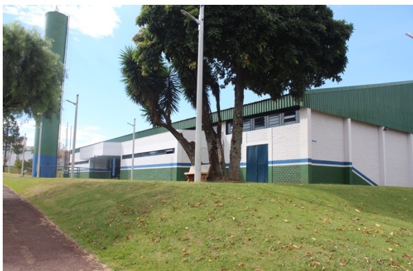
Figura 23 – Situação atual do Ginásio Municipal da Neva – Cascavel/PR
