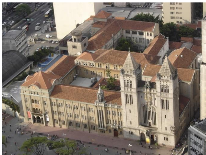
Figura 01: Mosteiro de São Bento - RJ
