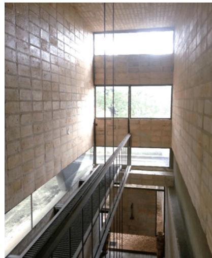
Figura 5 e 6 – Casa Fanego: Uso de tijolos aparente; Uso de tijolos mesclando-se com o aço.
