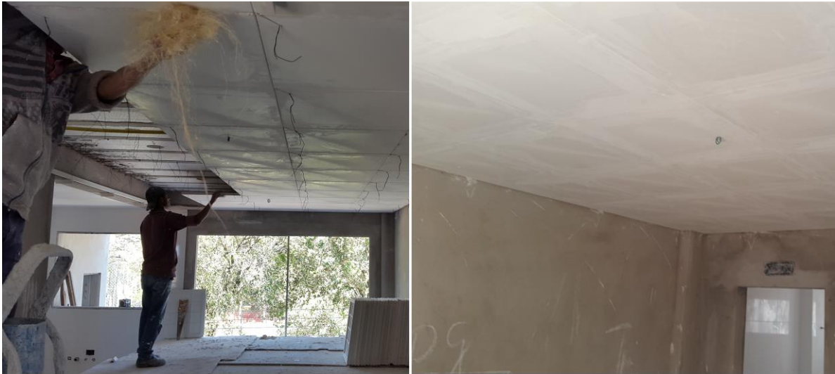
Figura 5: Montagem e acabamento do forro em placas.
