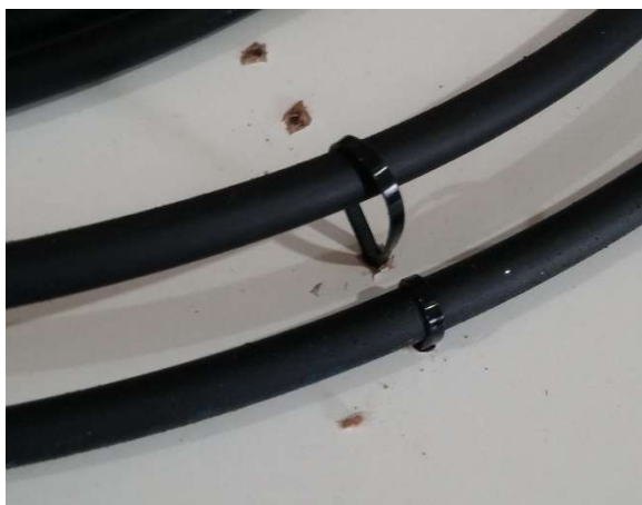
Figura 11 – Utilização das abraçadeiras plásticas
