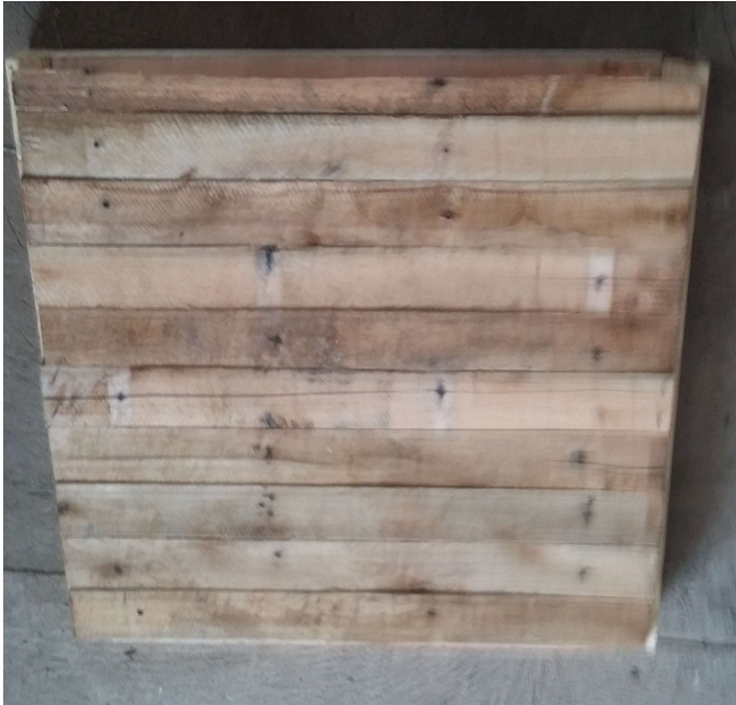
Figura 6 – Montagem do fundo da caixa
