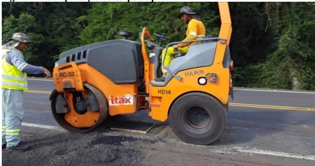
Figura 14: Compactação do corpo de prova.
