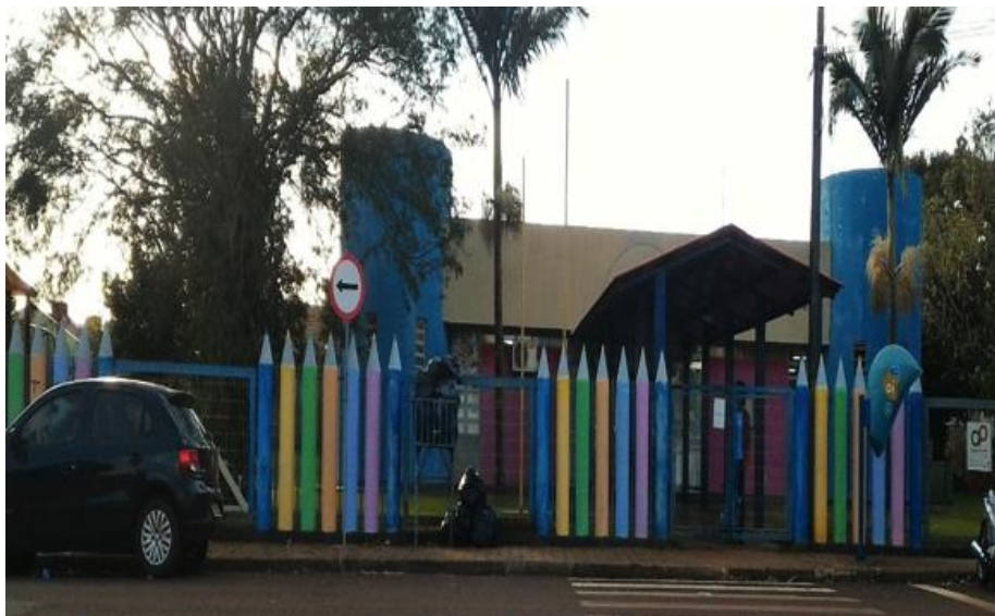
Figura 9: Fachada da edificação.
