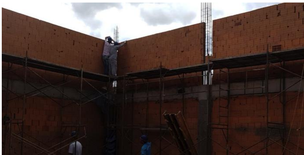
Figura 3: Parede de alvenaria já executada.
