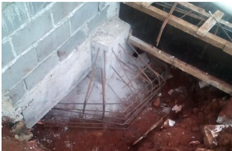
Figura 7: Execução de reforços na fundação.
