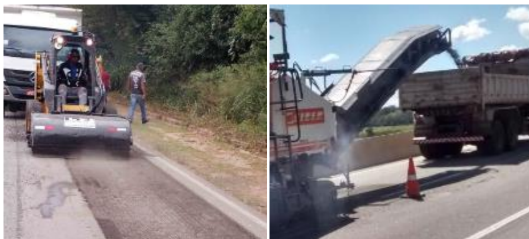
Figura 1: Fresagem com Bobcat x fresagem com W-1000.
