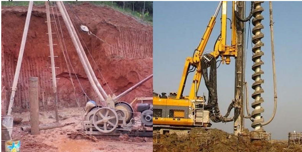
Figura 11: Representação da estaca Strauss e uma estaca Hélice Contínua Monitorada.
