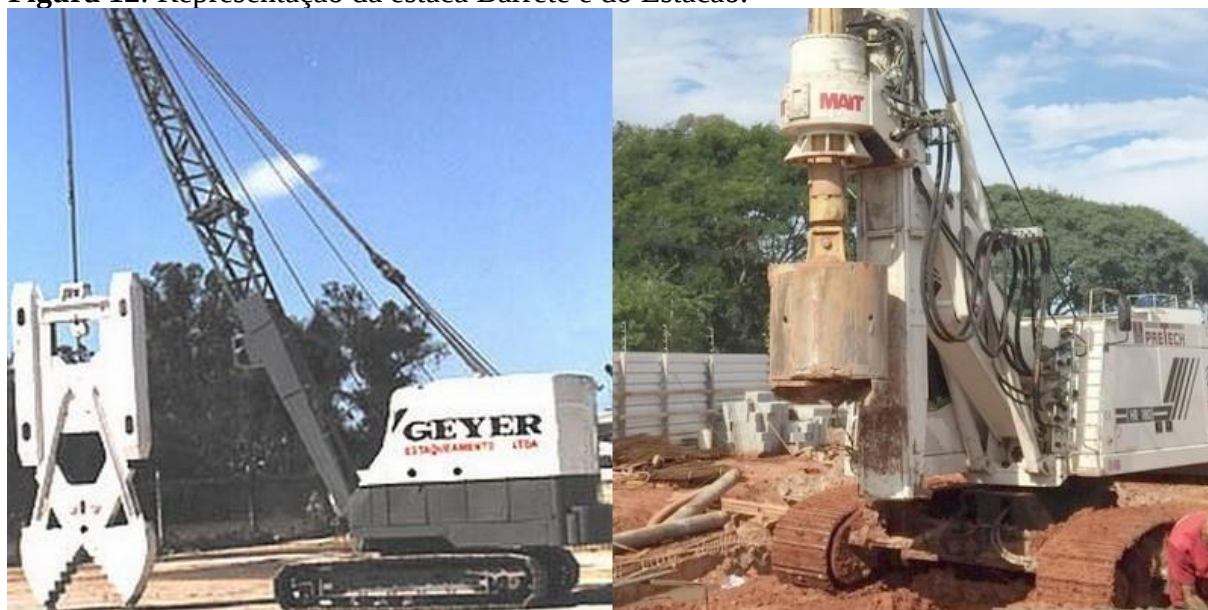
Figura 12: Representação da estaca Barrete e do Estacão.
