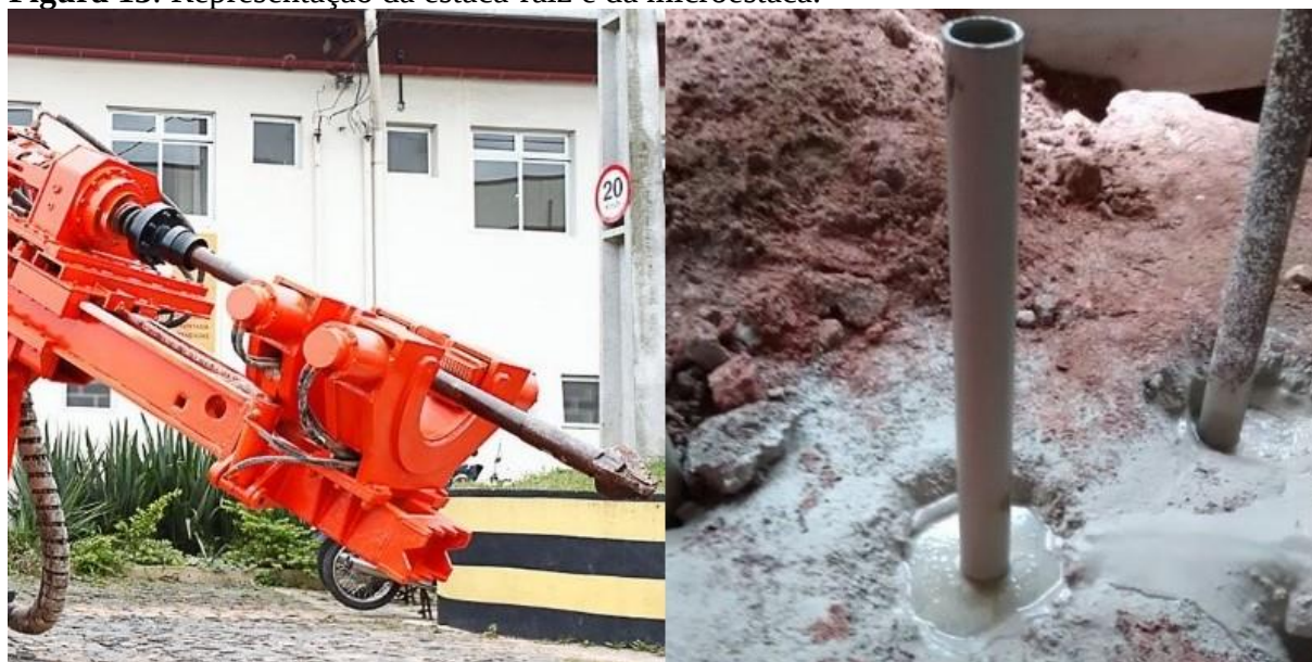
Figura 13: Representação da estaca-raiz e da microestaca.
