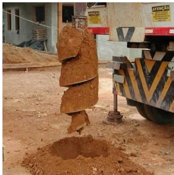
Figura 10: Representação da estaca broca escavada manualmente e da estaca escavada a trado mecânico.
