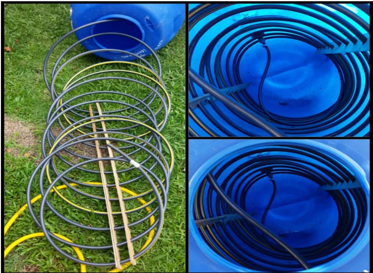
Figura 10 – Fabricação e instalação da serpentina de aquecimento.
