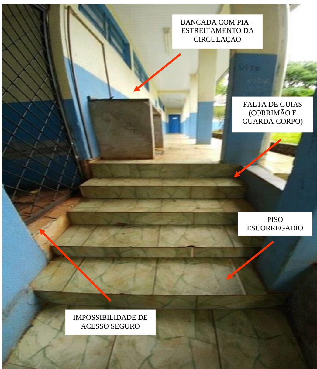
Figura 98: Área de acesso ao bloco de sala de aula
