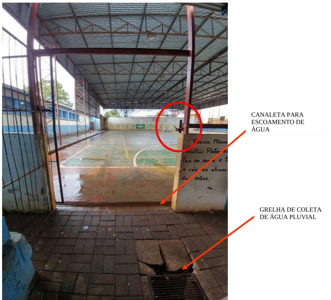
Figura 93: Área de acesso ao bloco de sala de aula
