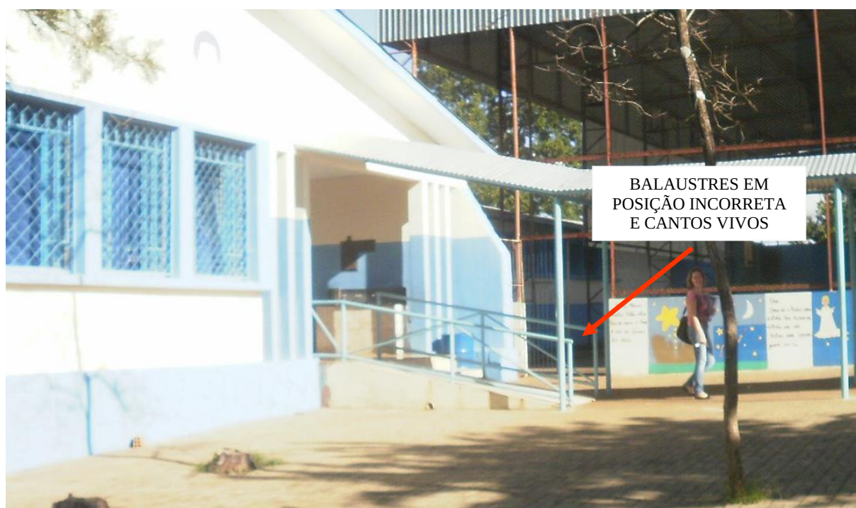
Figura 91: Detalhe corrimão da rampa
