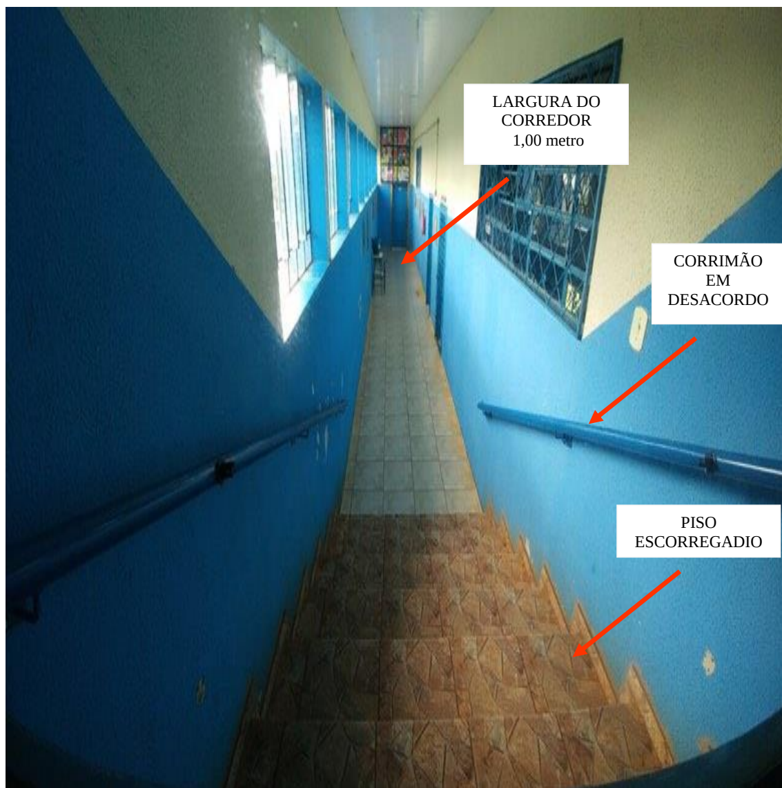
Figura 102: Escada e corredor de acesso às salas de aula Bloco II
