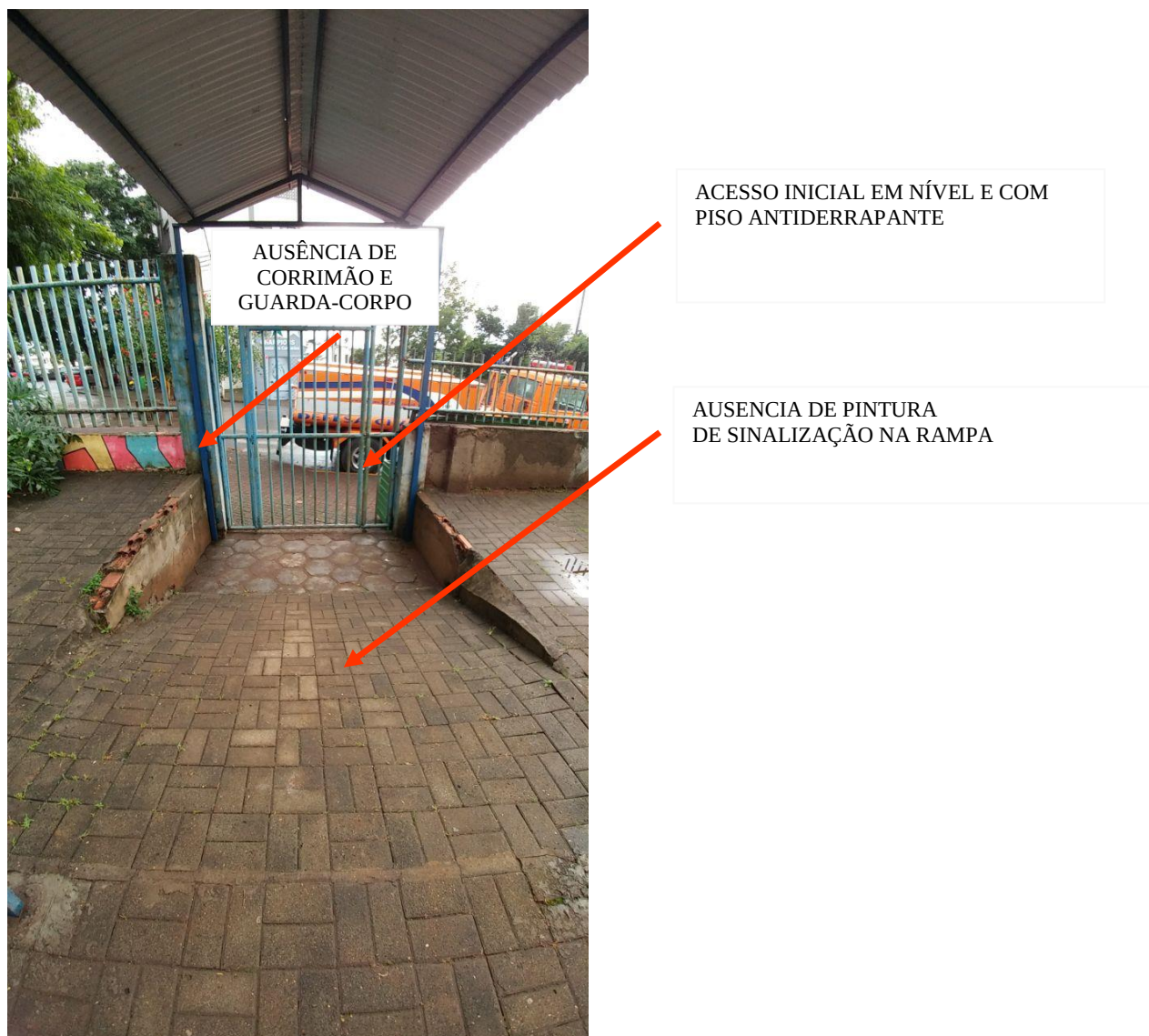
Figura 85: Acesso secundário do colégio.
