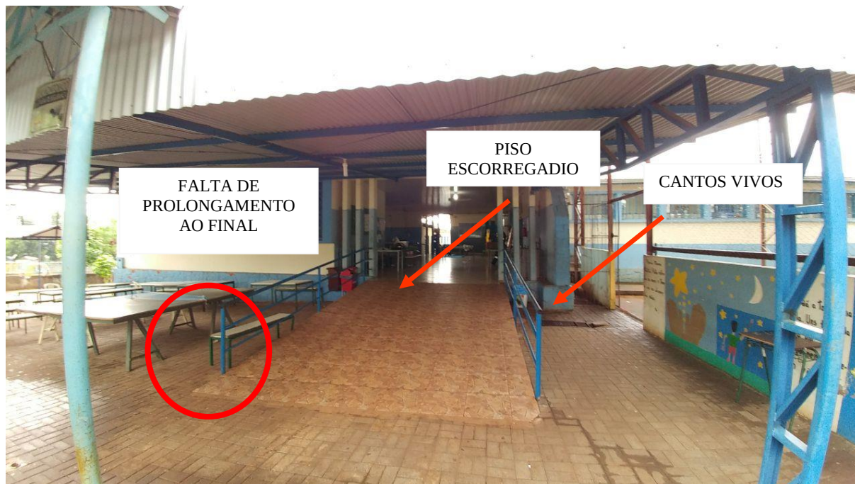
Figura 95: Área de acesso ao bloco de sala de aula e à cantina
