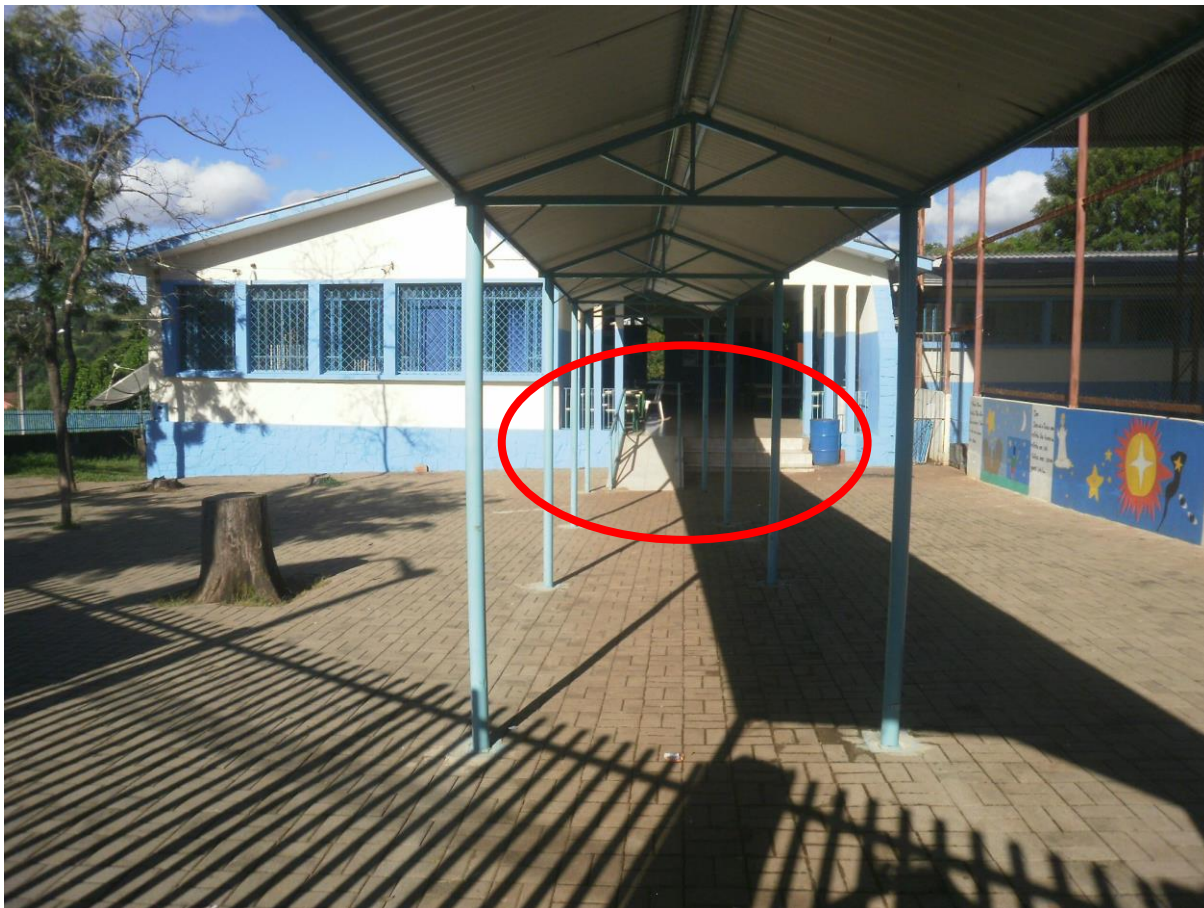
Figura 89: Área de acesso ao bloco de sala de aula
