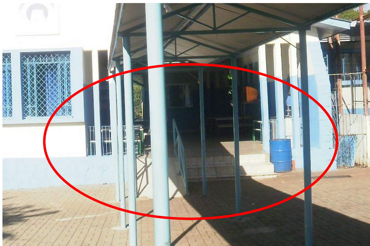
Figura 90: Rampa e escada de acesso
