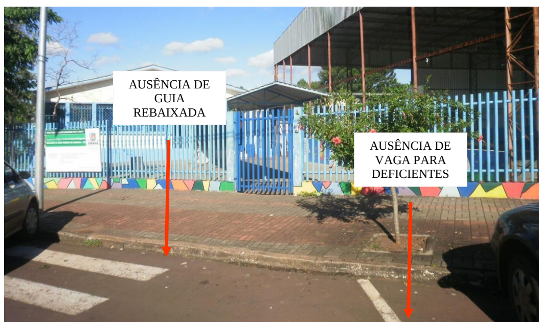
Figura 78: Falta de guia rebaixada e de vaga para deficientes no acesso ao colégio
