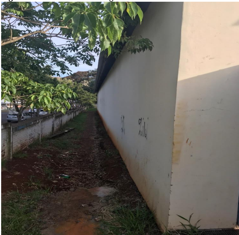
Figura 17: Fachada Sul do miniginásio.
