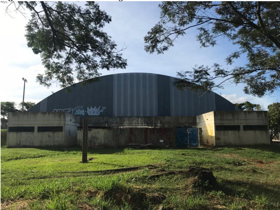
Figura 19: Fachada Oeste do miniginásio.
