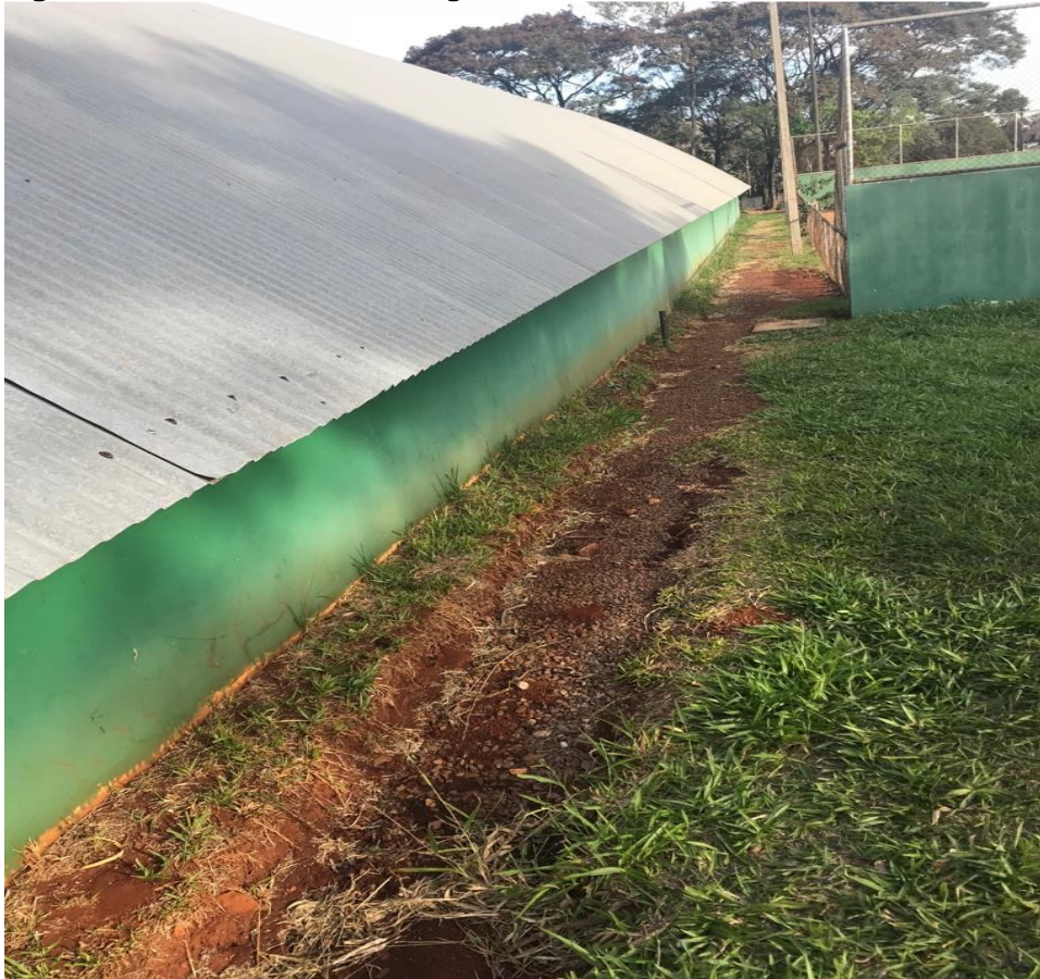
Figura 18: Fachada Norte do miniginásio.
