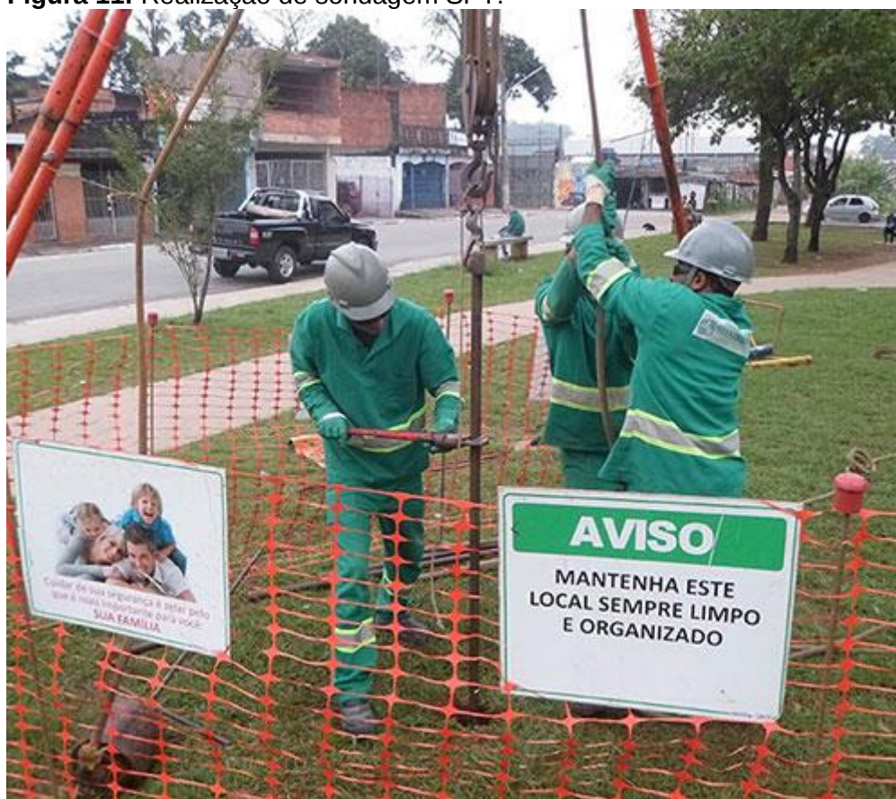
Figura 11: Realização de sondagem SPT.
