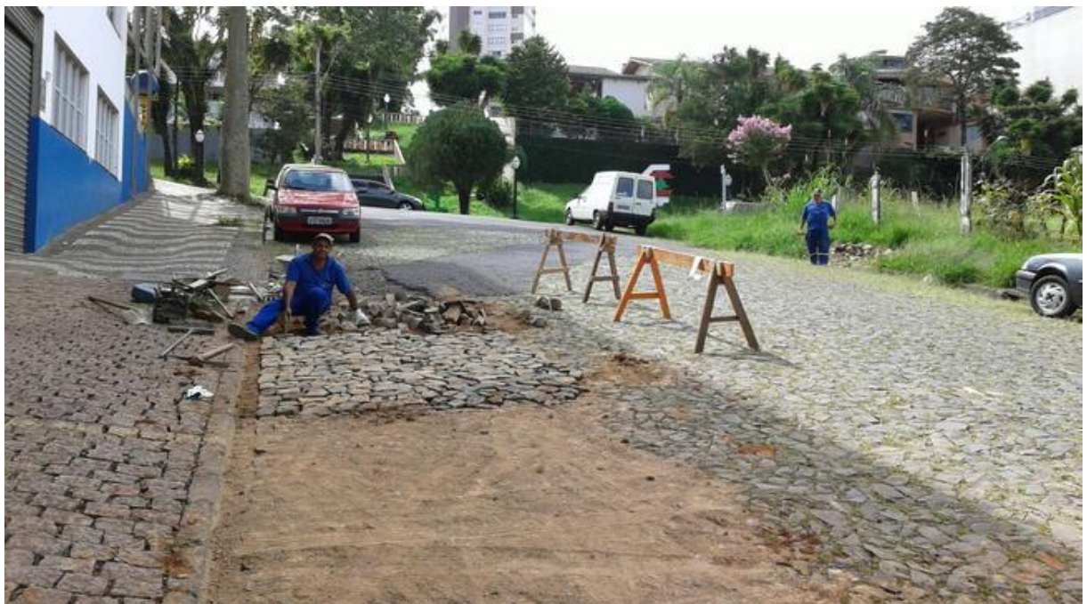
Figura 3 - Recuperação do pavimento.
