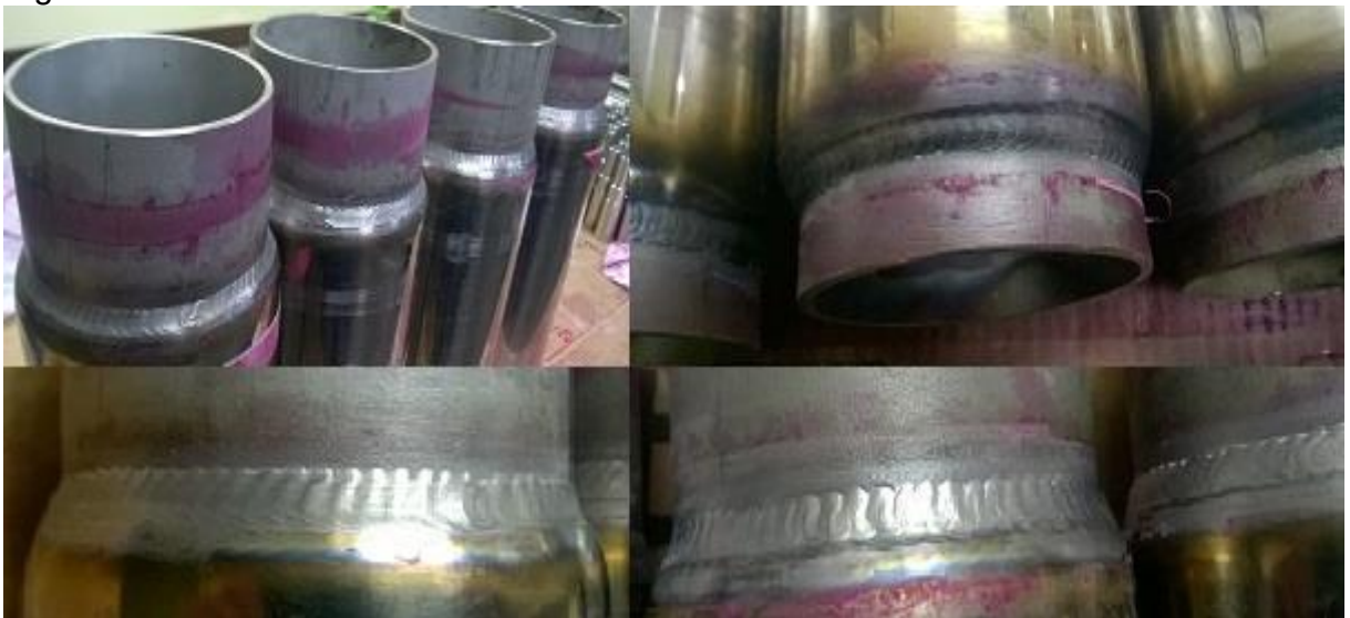
Figura 41 - Uniformidade dos cordões de solda
