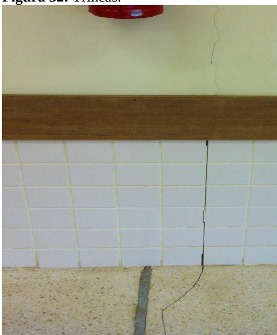
Figura 32: Trincas.
