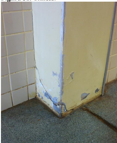
Figura 31: Trincas.
