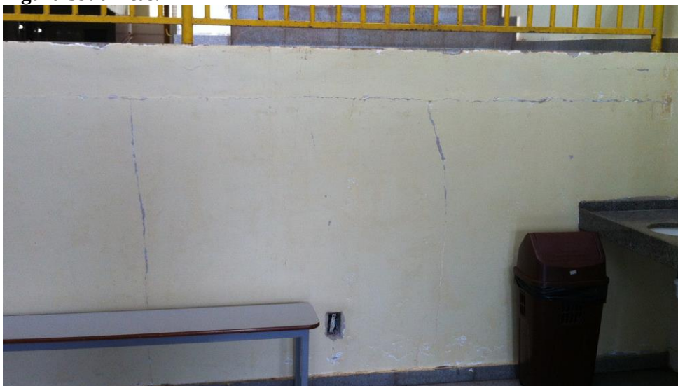
Figura 39: trincas.
