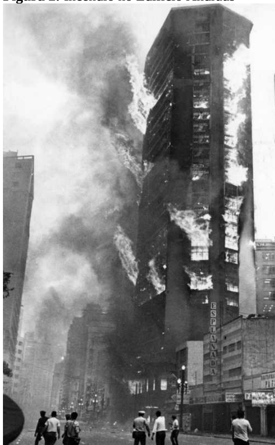
Figura 2: Incêndio no Edifício Andraus
