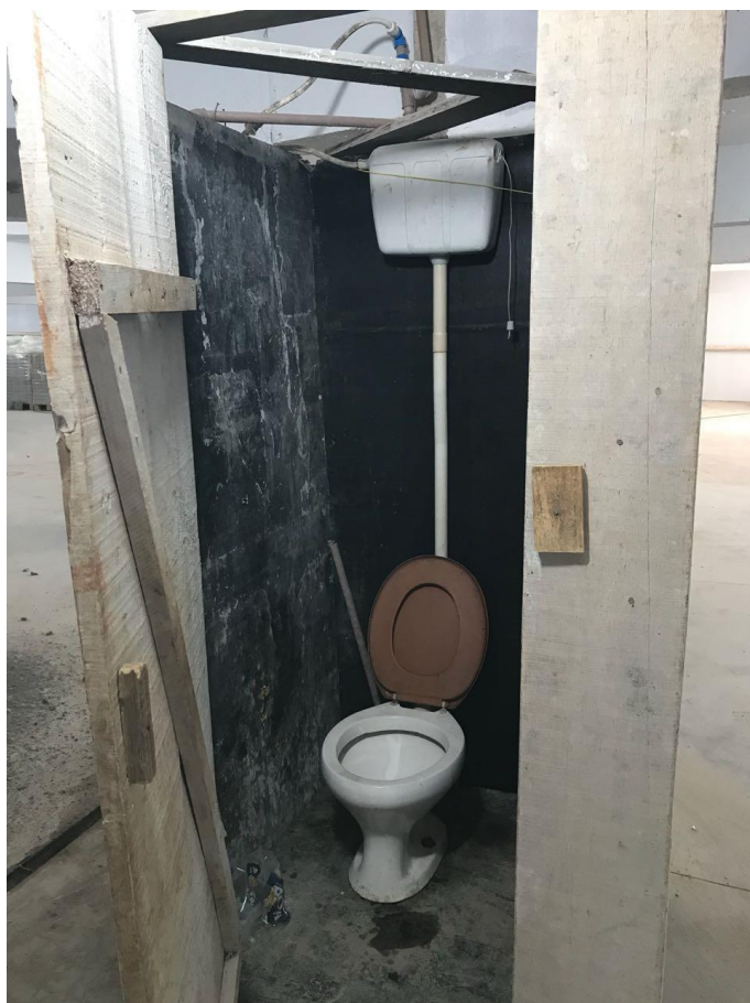
Figura 25: Instalação sanitária – Edifício B
