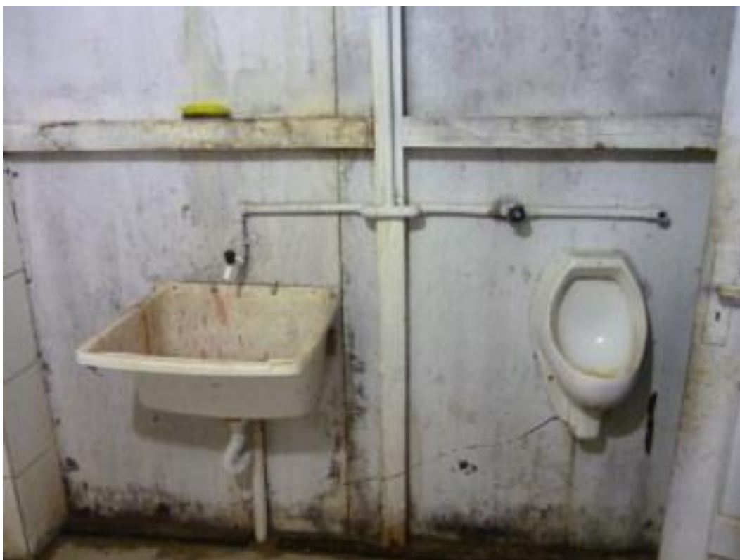
Figura 31: Instalação mictório – Edifício C
