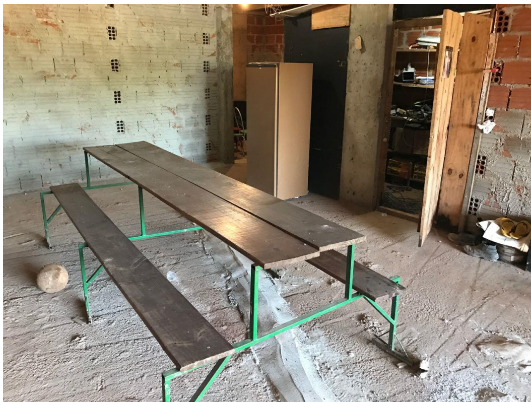
Figura 19: Mesa para refeições – Edifício A
