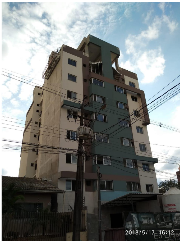
Figura 12: Edifício D – Cascavel, Paraná
