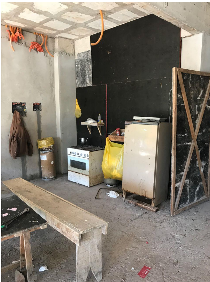
Figura 28: Instalação refeitório – Edifício B
