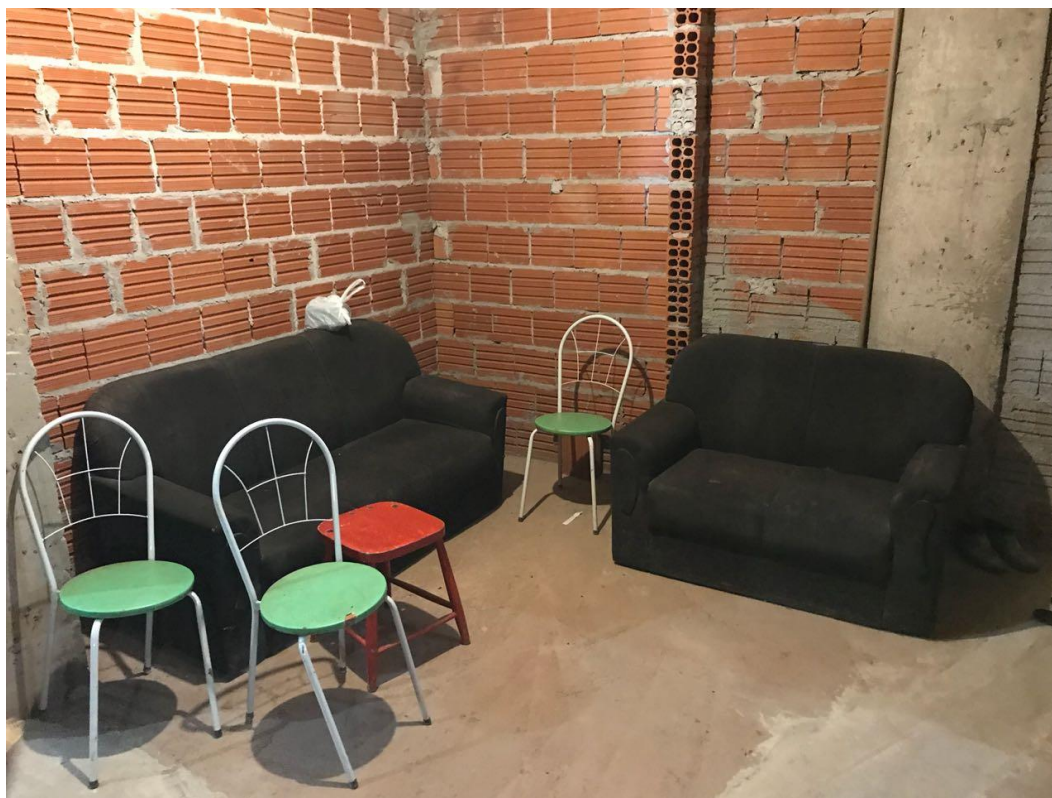
Figura 21: Instalações para descanso de funcionários – Edifício A
