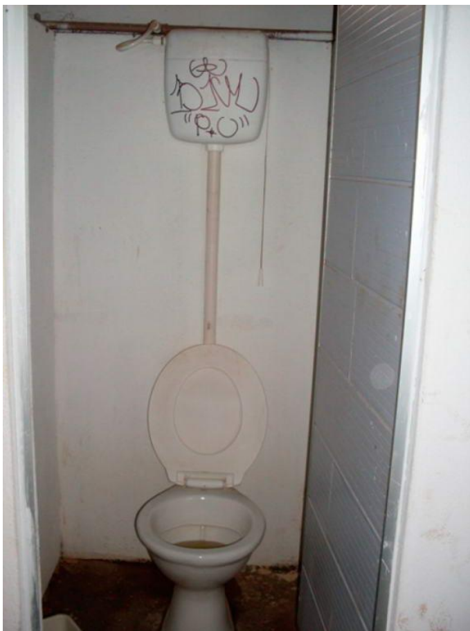
Figura 36: Bacia sanitária – Edifício D
