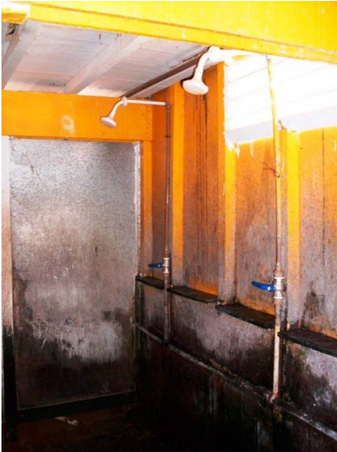
Figura 39: Área de banho vestiário – Edifício D
