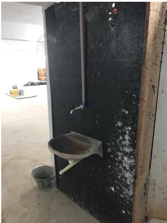
Figura 26: Instalação lavatório – Edifício B
