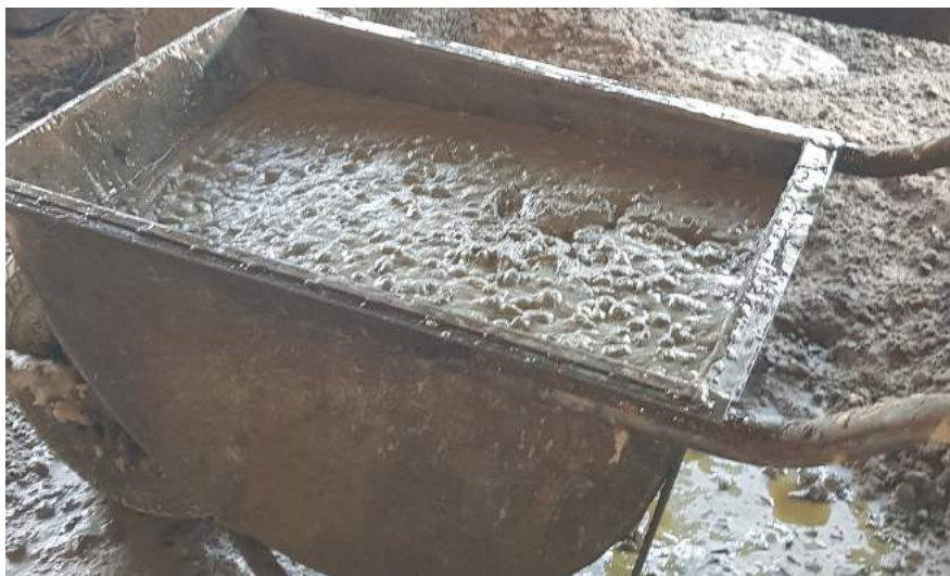
Figura 4: Concreto no estado fresco
