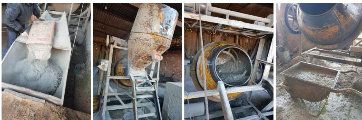
Figura 25: Processo de fabricação do concreto fresco
