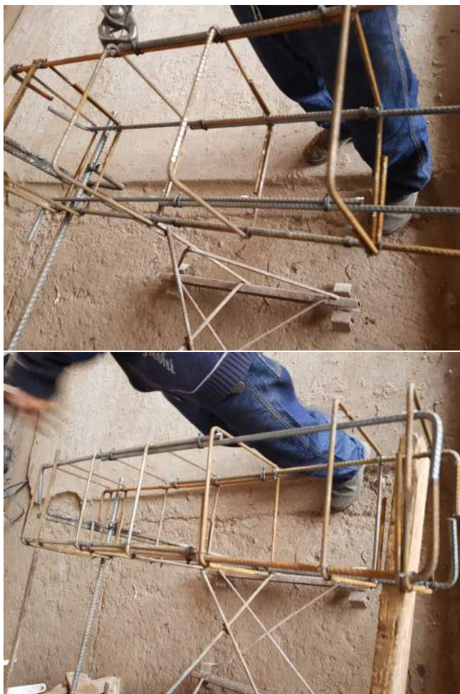
Figura 29: Processo de armação das armaduras de aço
