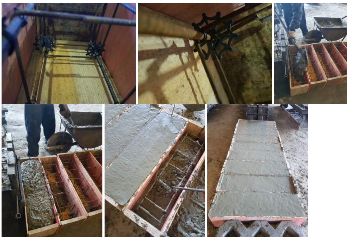
Figura 34: Formas confeccionadas em madeira
