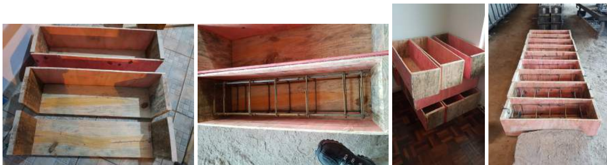
Figura 33: Formas confeccionadas em madeira
