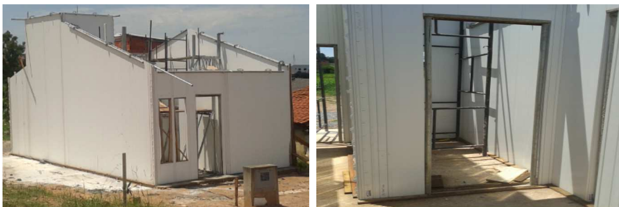
Figura 13: Travamento da parte superior e das janelas.
