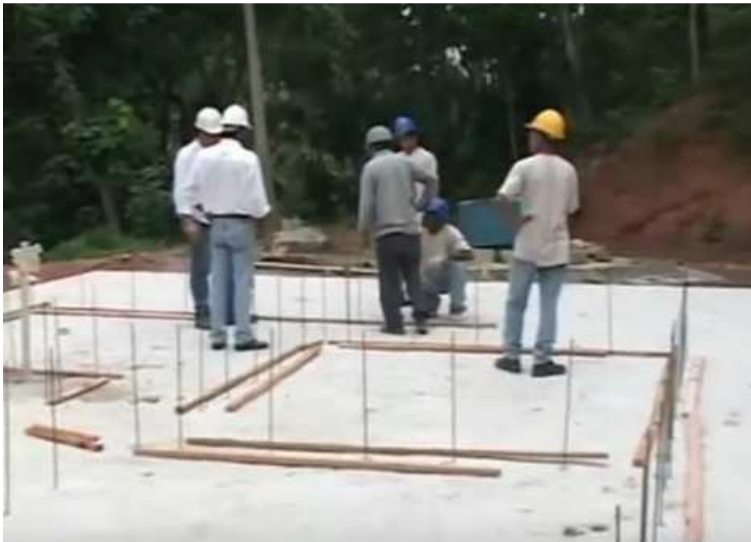
Figura 6: Gabarito execução e posicionamento das agulhas.
