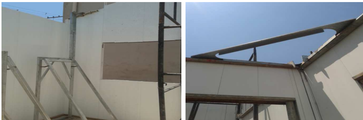
Figura 12: Escoramento dos painéis.
