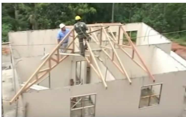
Figura 16: Montagem da Cobertura.
