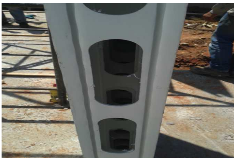
Figura 8: Alvéolos e tipo de encaixe do módulo.
