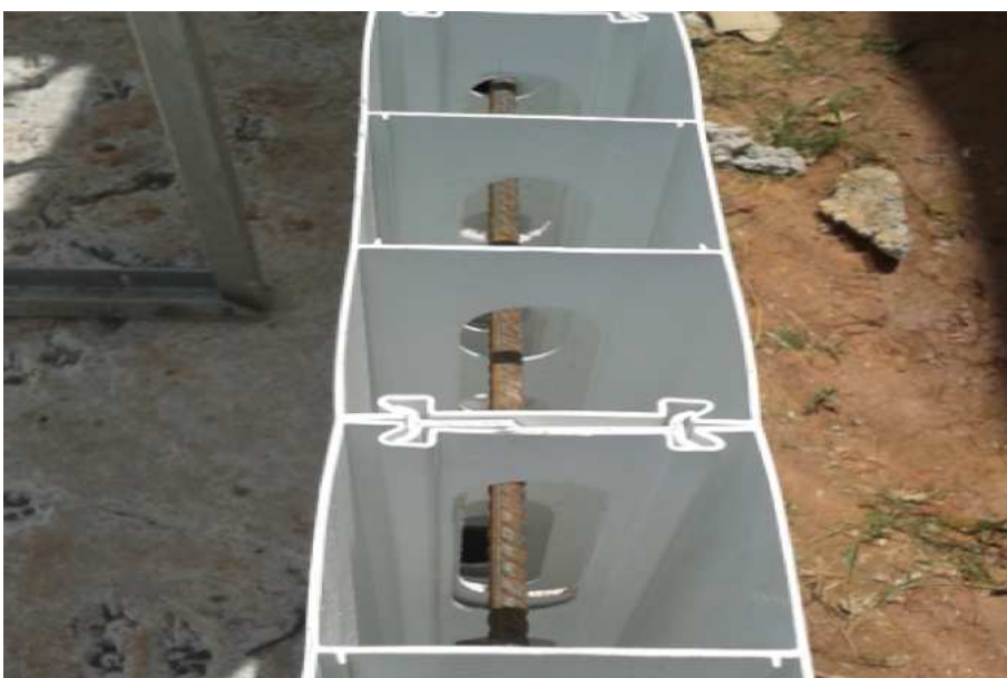
Figura 11: Montagem dos módulos.
