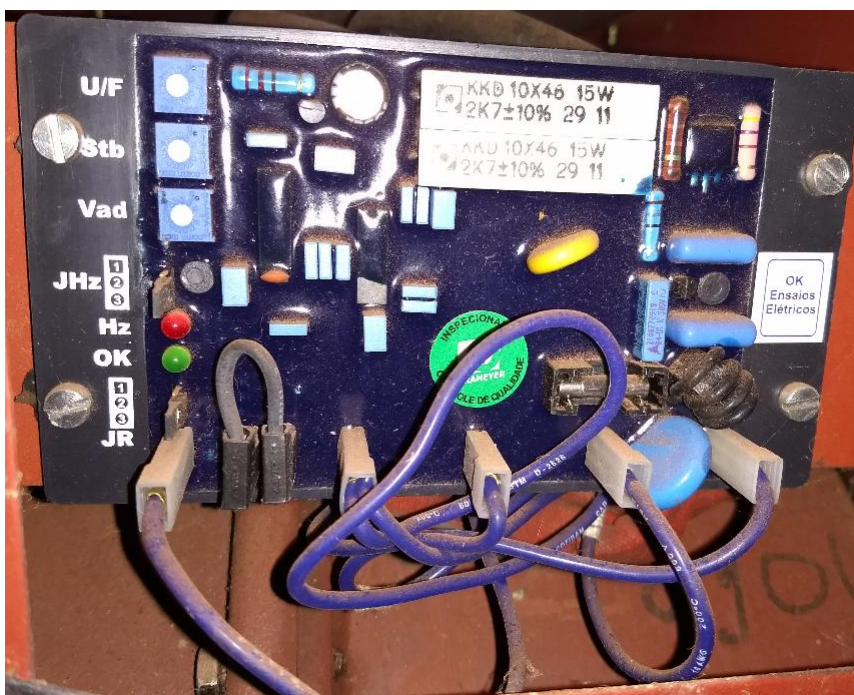
Figura 8: Placa controle excitação GMG2.
