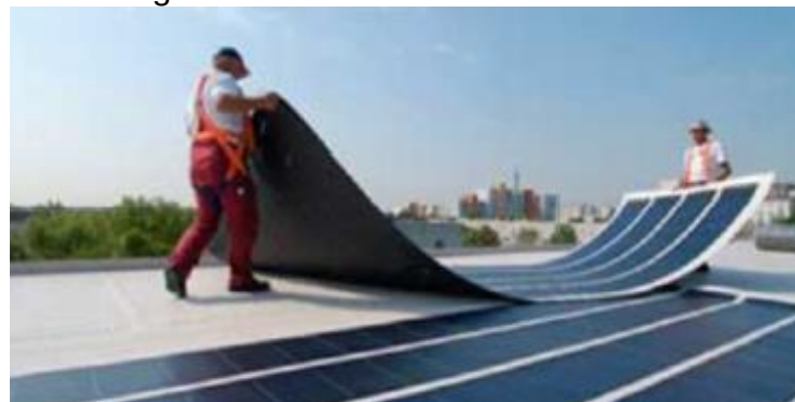
Figura 14 - Células de silício amorfo.
