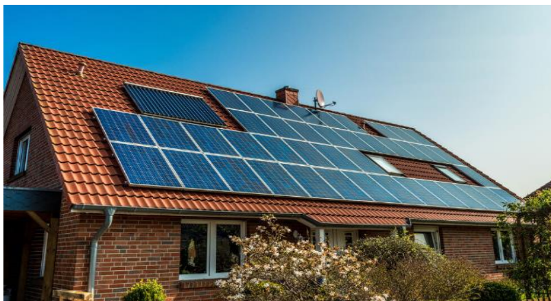
Figura 9 – Placas solares instaladas em telhado de residência
