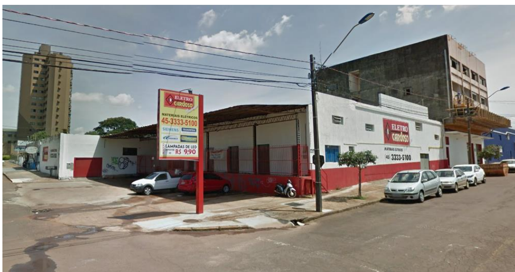
Figura 4 - Fachadas leste e sul da empresa
