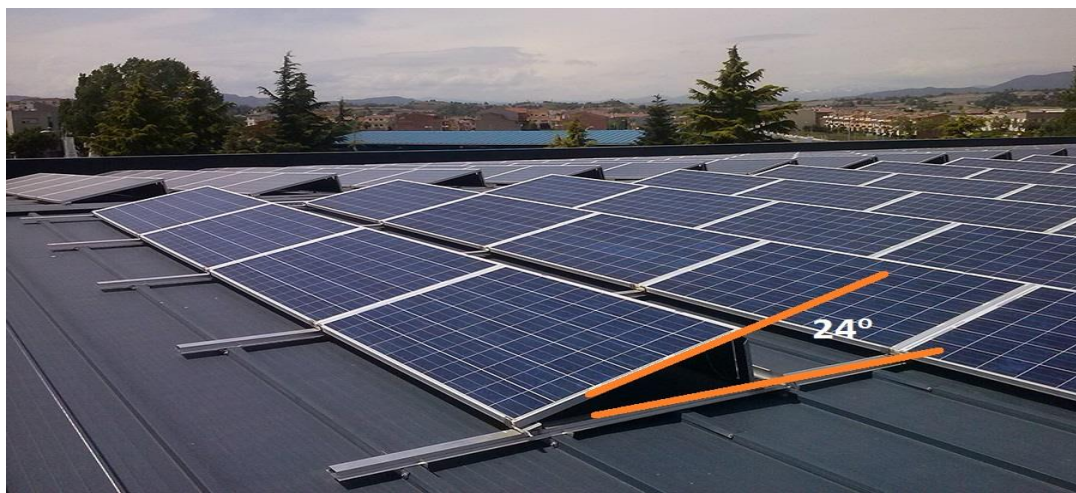
Figura 19: fixação dos painéis fotovoltaicos
