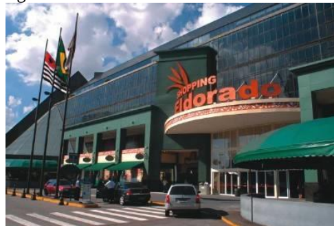
Figura 4: Fachada com elementos na cor verde
