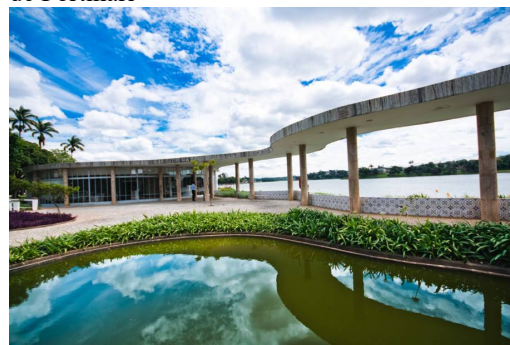
Figura 4- Marquise, maciço de agapantos e cerâmica de Portinari
