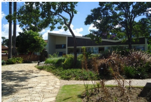
Figura 6- Fachada principal, calçadas e Acesso para Carros
