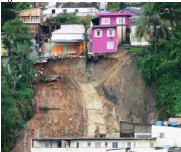
Figura 5 - Deslizamento na Grande Florianópolis
