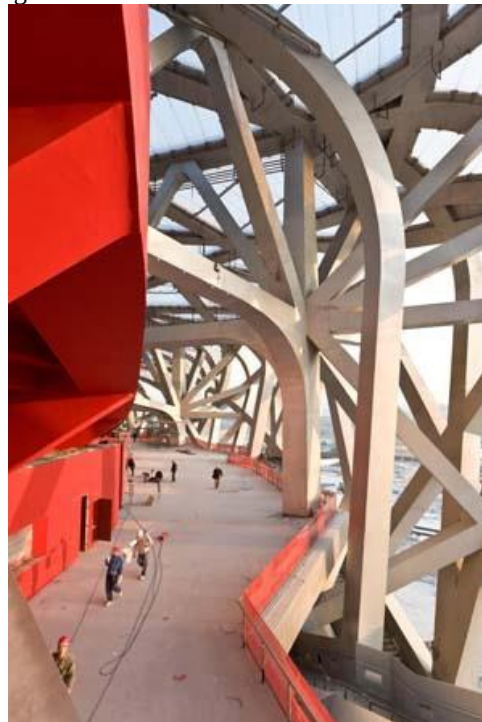
Figura 12: Detalhes em vista da forma estrutural
