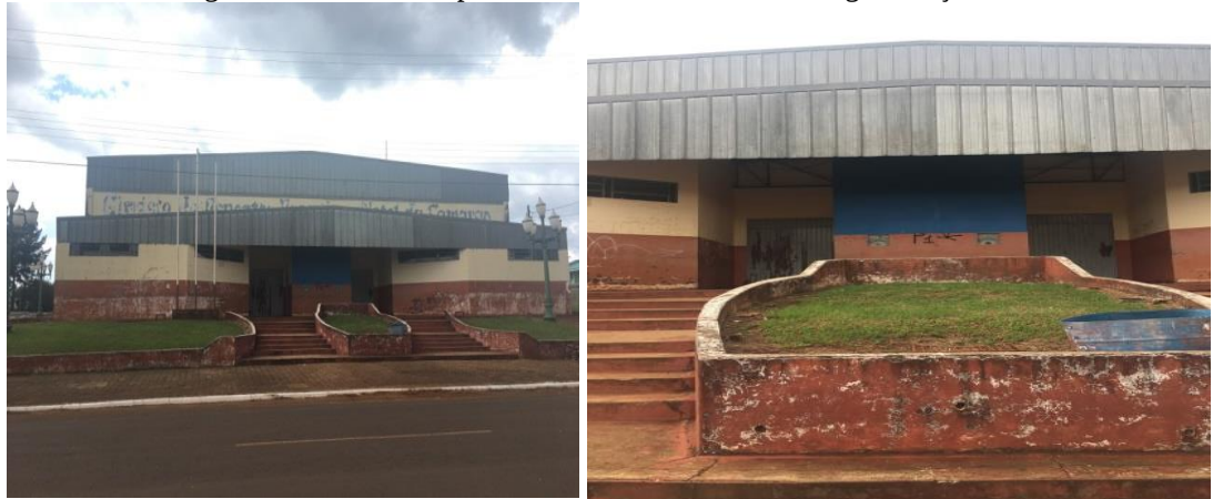
Figura 31: Centro de esportes Francisco Natel de Camargo situação atual.
