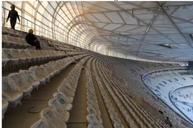
Figura 11: Vista interna com a grelha da cobertura
