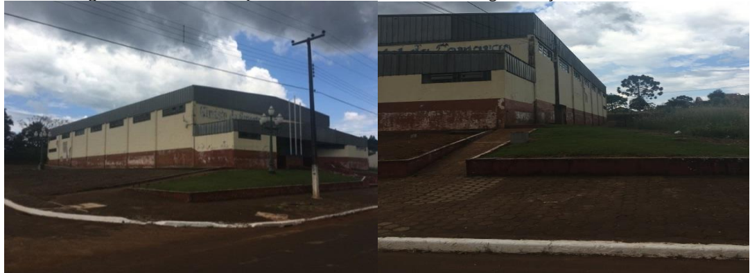
Figura 32: Centro de esportes Francisco Natel de Camargo situação atual.
