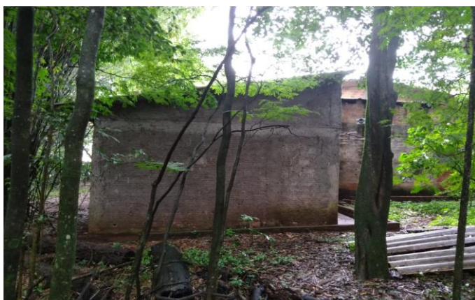
Figura 13 – Fachada Leste, fundos do depósito
