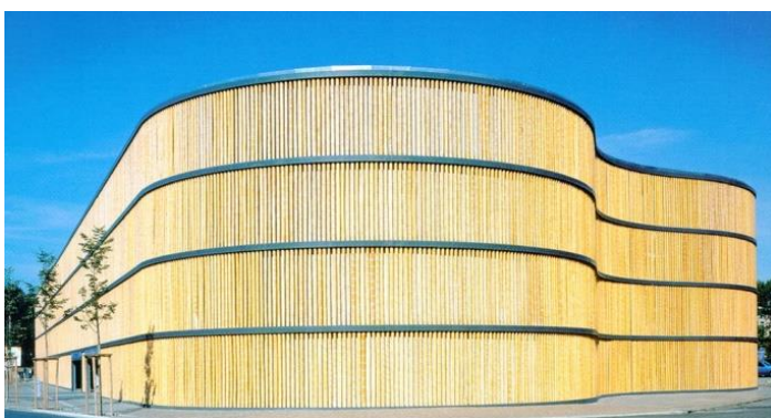
Figura 4 – Vista aproximada da lateral do estacionamento
