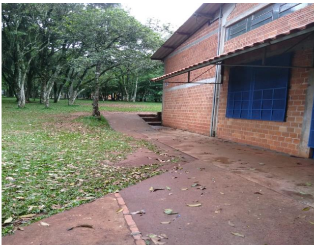
Figura 8 – Fachada Oeste, ênfase na rampa de acesso
