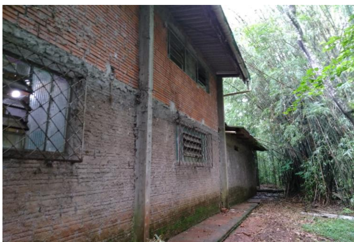
Figura 16 – Fachada Oeste voltada aos fundos
