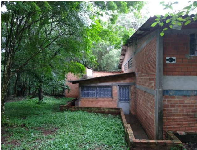
Figura 10 – Continuação da fachada Norte
