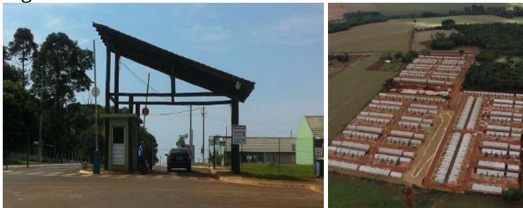
Figura 24: Portal de acesso e vista aérea do condomínio Pantanal.
