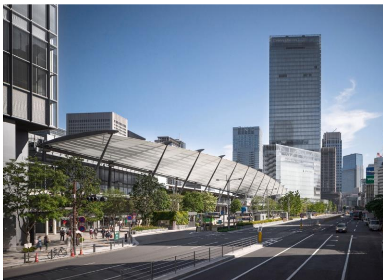
Figura 14: Reforma da estação de Tóquio Yaesu
