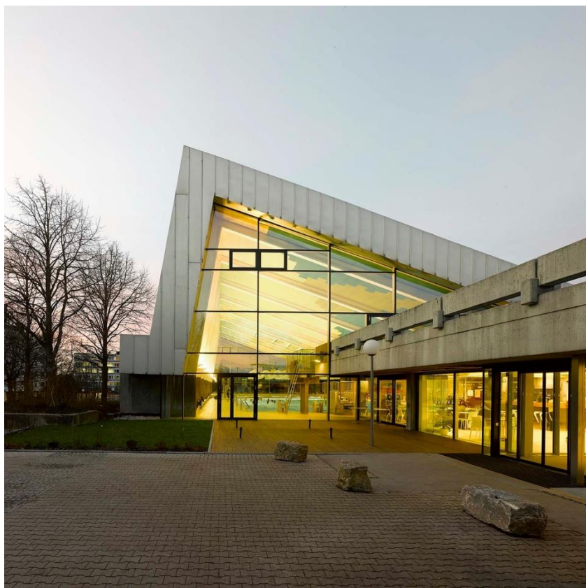
Figura 12: Fachada do Centro Esportivo em Leonberg
