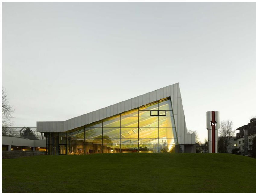
Figura 13: Detalhe em vidro da fachada do Centro Esportivo em Leonberg
