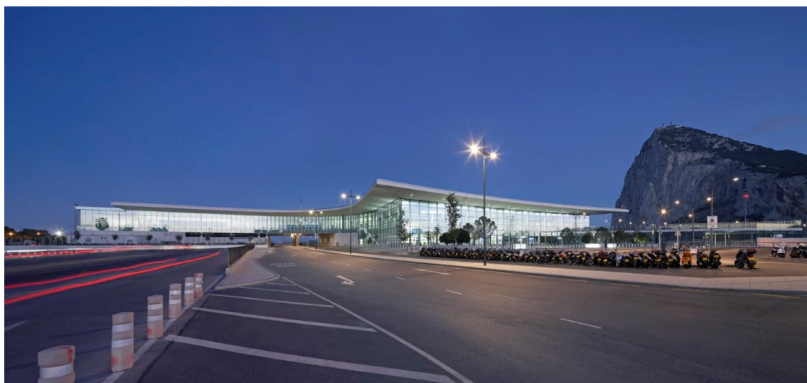
Figura 04: Edifício Arquitetônico do Aeroporto de Gibraltar
