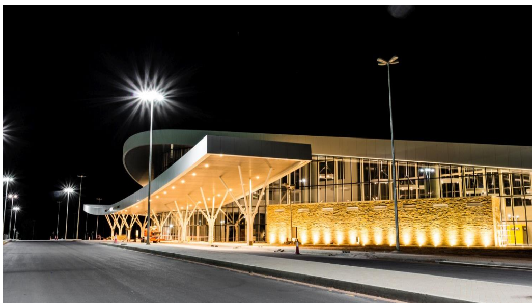
Figura 11: Estrutura e cobertura do Aeroporto.
