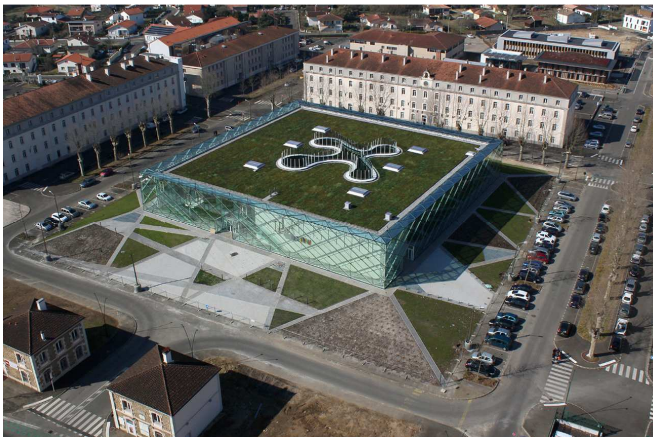
Figura 08- Vista do Entorno
