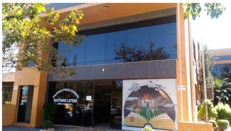
Figura 4 – atual biblioteca pública municipal
