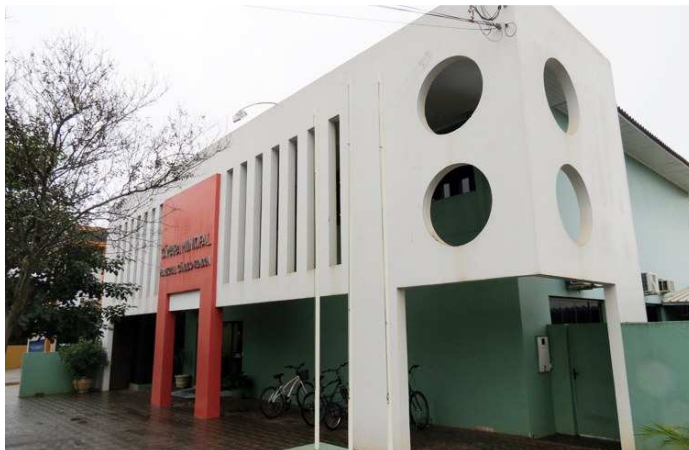
Figura1 – 1 biblioteca de Marechal, atualmente reformada para câmara de vereadores
