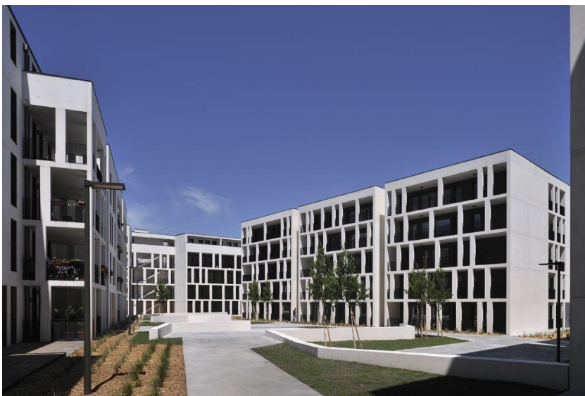
Figura 09 – vista do pátio central -forma
