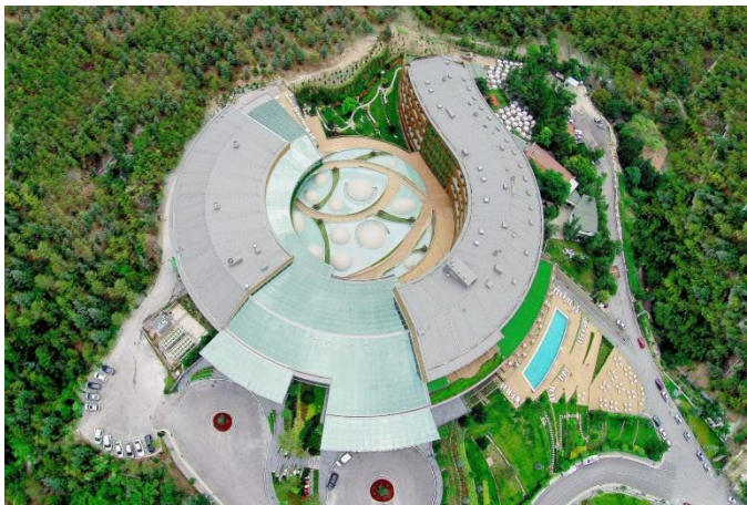
Figura 06 - Vista dos terraços e cobertura da piscina com cúpulas.
