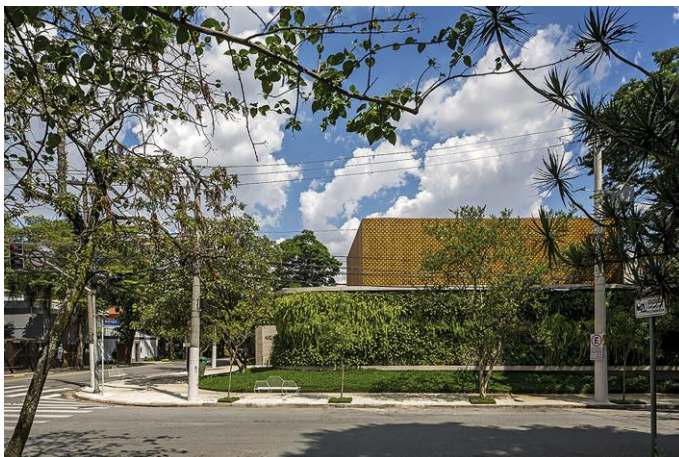
Figura 08 - Fachada de concreto com jardim vertical.
