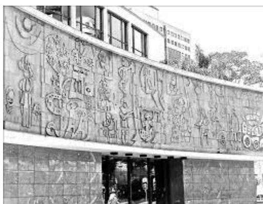
Figura 06: Fachada em concreto bruto Teatro Guaíra-PR
