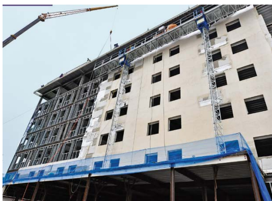
Figura 22- Fechamento em Placa Cimentícia
