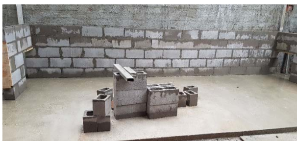
Figura 3 - Alvenaria estrutural - blocos com junta amarrada
