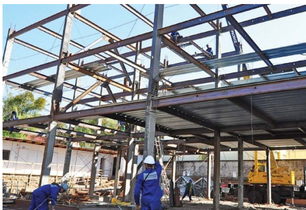
Figura 20 - Montagem da Estrutura Mista
