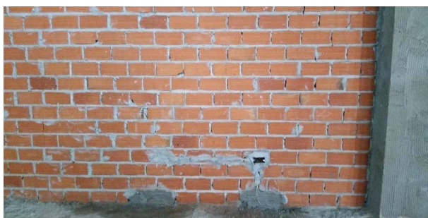
Figura 2 - Vedação em Alvenaria
