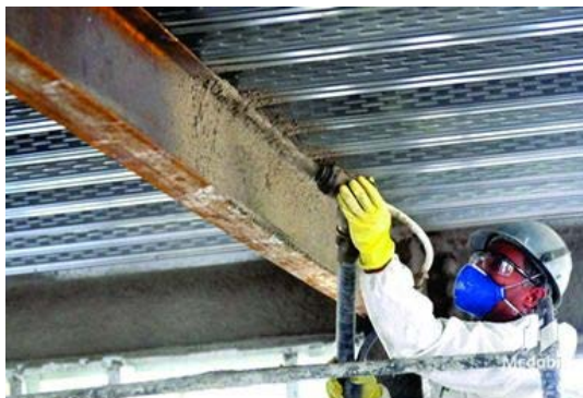
Figura 21 - Preenchimento parcial da estrutura metálica com concreto
