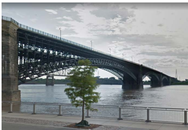
Figura 8 - Ponte Eads – St. Louis, EUA
