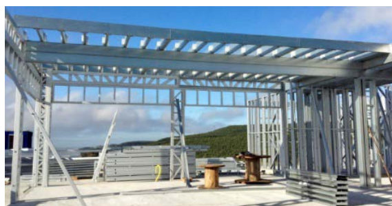
Figura 12 - Montagem da Estrutura em LSF
