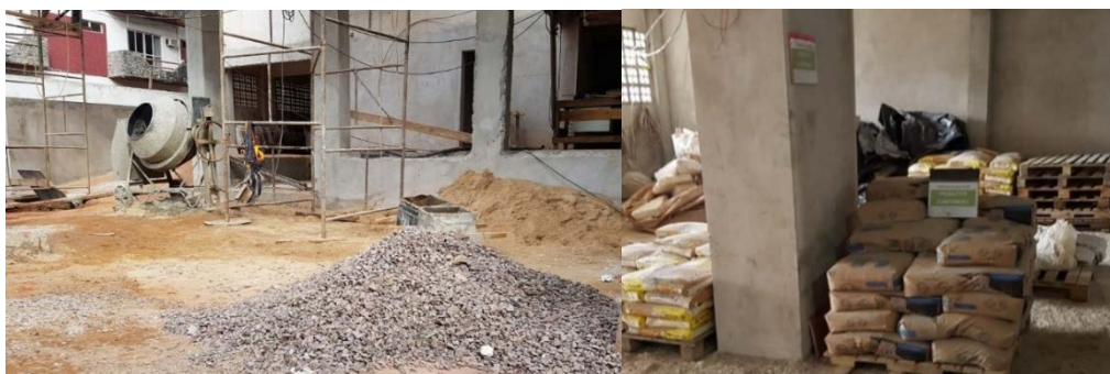
Figura 4 - Armazenamento de areia e brita, próximo à betoneira e armazenamento de cimento
