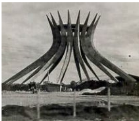
Estrutura dos pilares e detalhe da construção do anel de tração na base da Catedral de Brasília, 1959. Foto: Marcel Gautherot. Fonte: Underwood (2003, p. 84).
