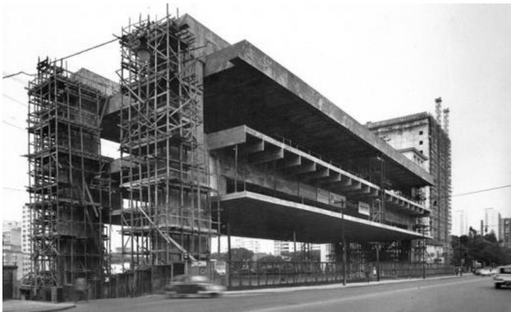
Figura 4 – Construção do edifício
