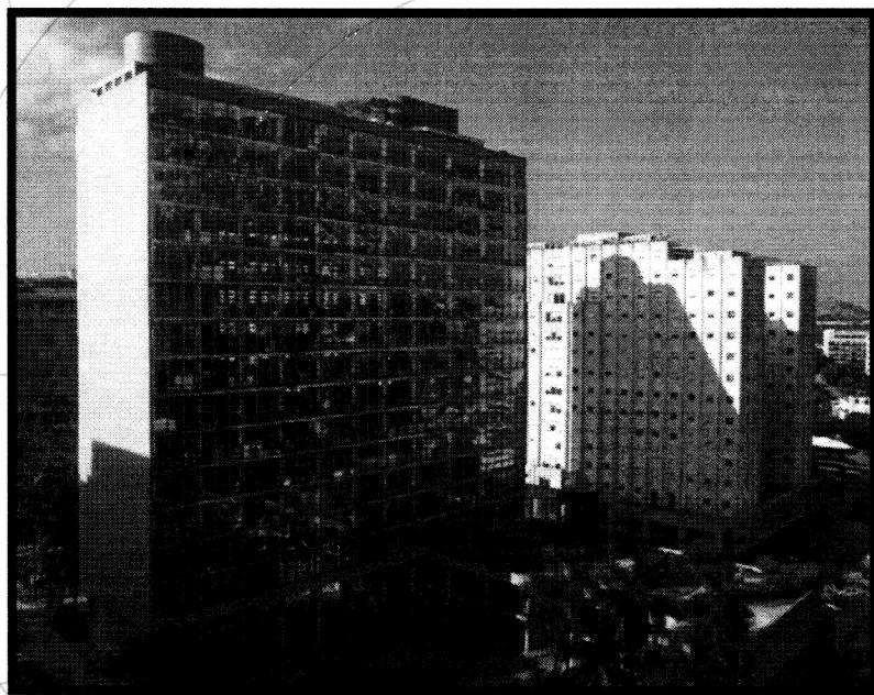
Imagem 01 - Edifício Gustavo Capanema / Ministério da Educação e Saúde Pública < http://portal.iphan.gov.br/uploads/ckfinder/images/Diversas/RJ_Rio_de_Janeiro/1_Pal_Gustavo_Capanema_Fachada_Sul_Foto_Oscar_Liberal.jpg >
